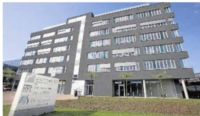
„Kenersys“ im neuen Bürohaus Portal 10 am Hafen. Das weltweit tätige Unternehmen fühlt sich in Münster wohl.
