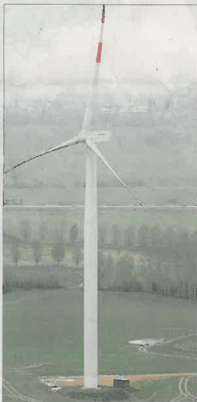
Die Windkraftanlage der Stadtwerke hat 80 Meter Nabenhöhe und eine Leistung von zwei Megawatt.
